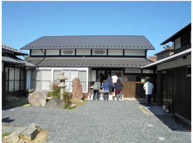
写真②グループホームの外観
