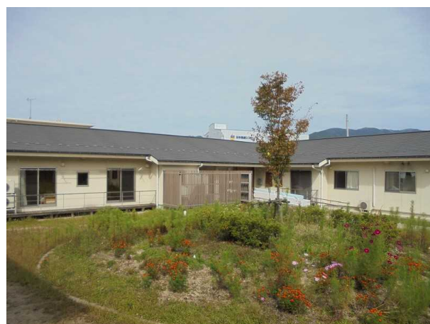
ショートステイ棟(写真11)
